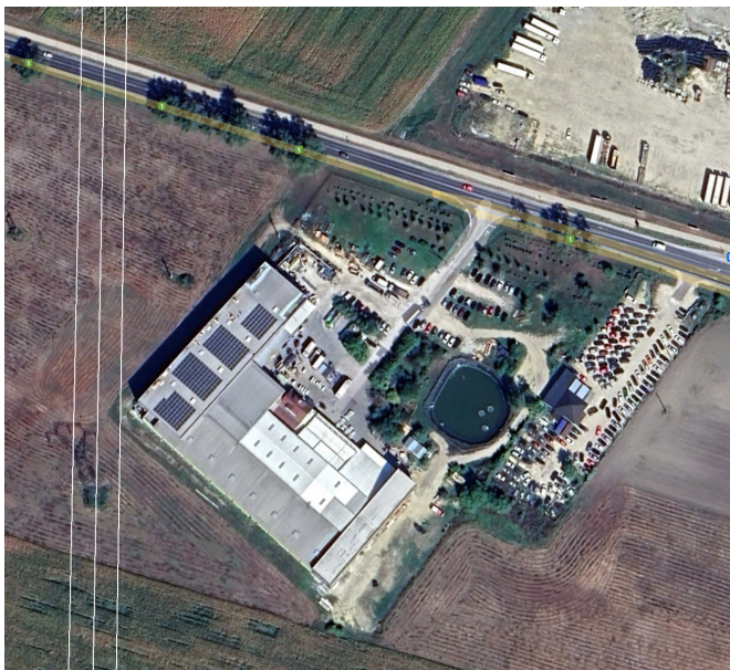
1. ÁBRA: A jelenleg is érvényes védőtávolság-előírások negligálása: 400kV-os légtávvezeték szélső szála a 2004-ben épült Győr, Bécsi úti ipari csarnoktól mindössze kb. 8 m-re, az előírt 28 m helyett [a szerző mérése, Google Earth [1]]
