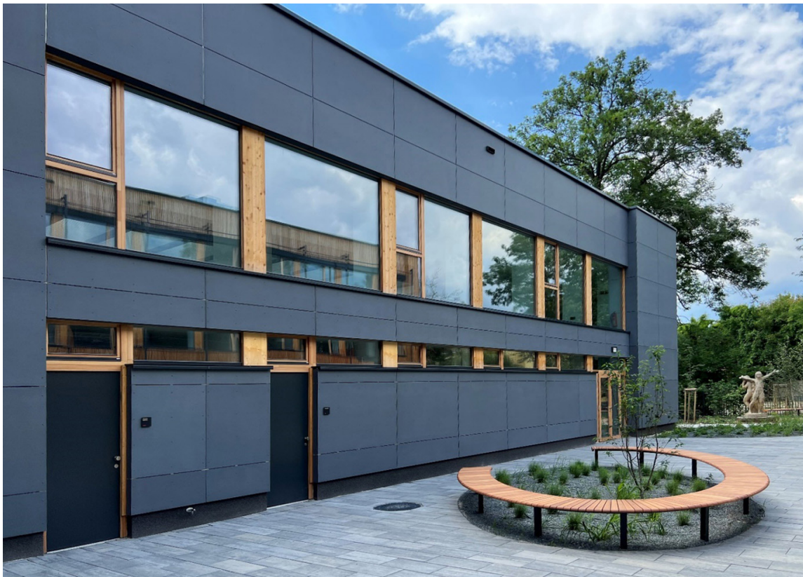
1. ÁBRA: Egy átszellőztetett homlokzatburkolattal kialakított épület, a Českobrodská Technikum felújított sportcsarnoka Prágában (fotó: NB)
