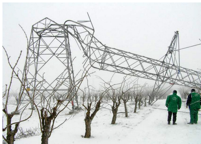
7. ÁBRA: Zord időjárás miatt egy 400 kV-os távvezetéken 14, egy 220 kV-oson 6 oszlop dőlt ki, és 87 oszlop megsérült Kelet-Magyarországon 2014-ben [26]
