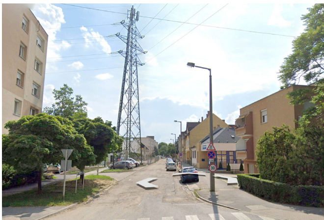
3. ÁBRA: 132 kV-os távvezeték Győr sűrűn lakott részén, a nádorvárosi városárcsarnoknál, amely a közeli Tihanyi Árpád utcai lakóházak felett is áthalad (fotó: Google Earth [10])
