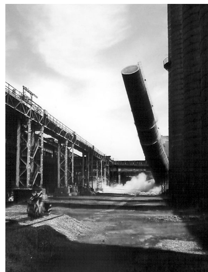
4. ÁBRA: A kémények bontása [4]
